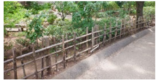
2020年老朽化状況
