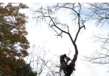
サクラの危険枝の切除作業中
