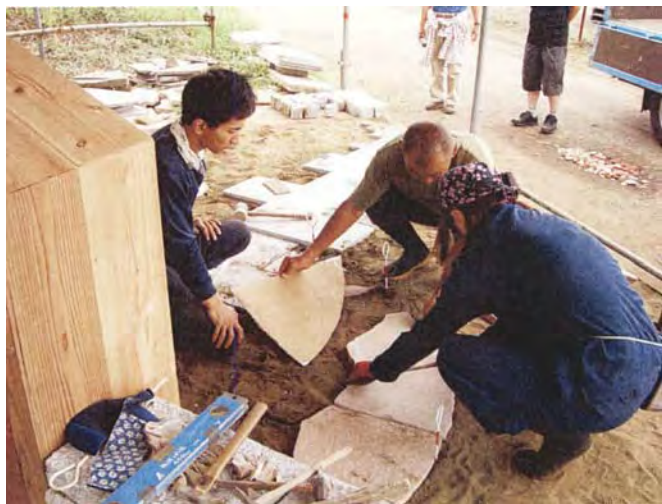
【石張り石材】 加工した石材を現場に合わせ調整
