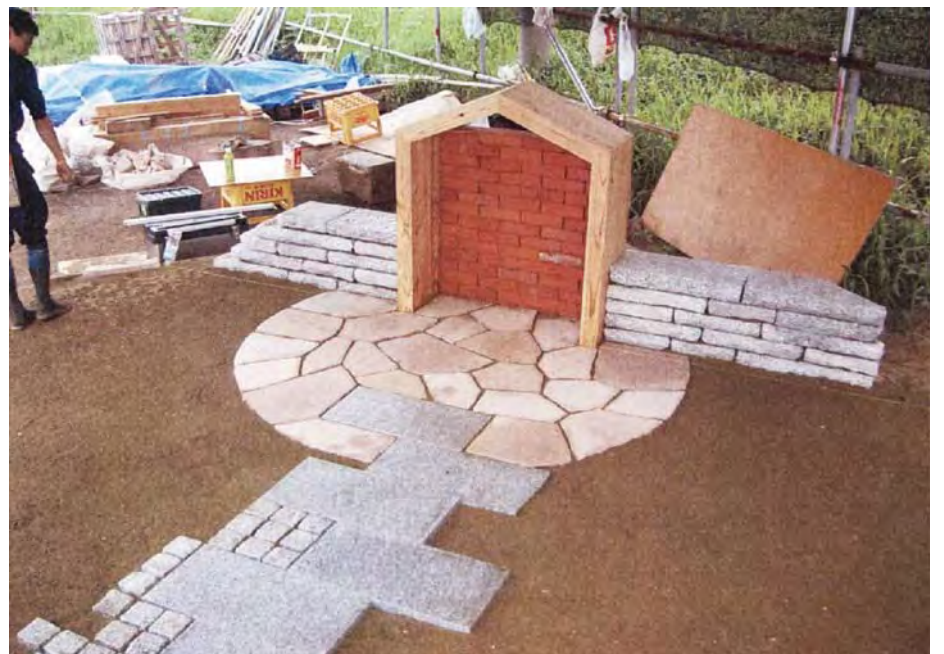
【完成】 周辺の地盤を整地して水洗いしすべての作業を終了、完成をみる。
