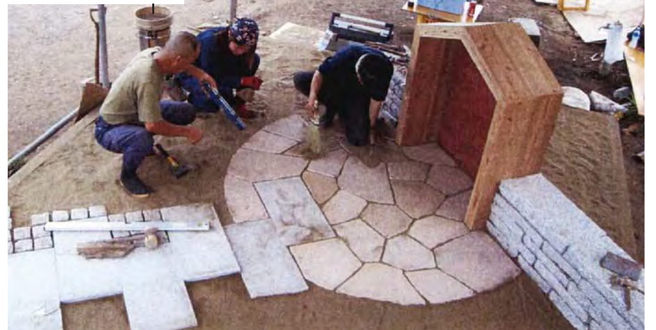
【目地砂詰め込み】 最後の一枚を貼り付け、高さを調整しながら目地を詰める。
