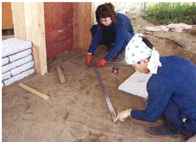
【石張り工事準備】 基準点より石張り範囲割り付け状況
