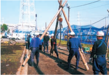
三又を安全且つ素早く移動するための作業。レッカー使用には無い呼吸合わせを学ぶ
