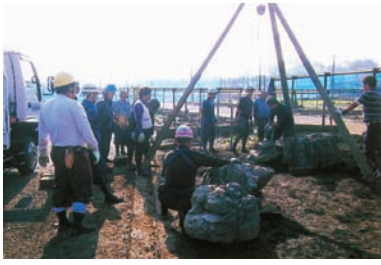
三又による景石の据え付け。繊細さが求められる。玉掛けのむずかしさを学ぶ
