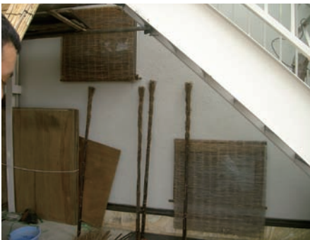
立会垣下拵え完了
