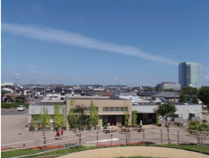
「自然環境の保全と活用」として、太陽光発電施設の設置（リバースオクションによる設置を予定している相模三川公園パークセンター）
