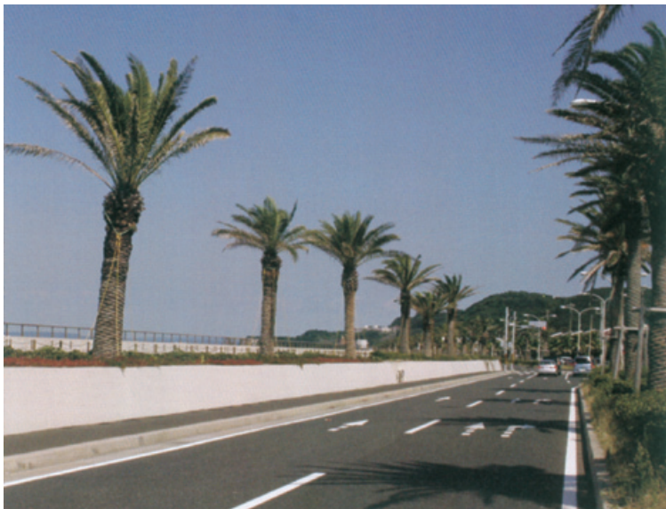
馬堀海岸高潮対策護岸と緑陰道路
