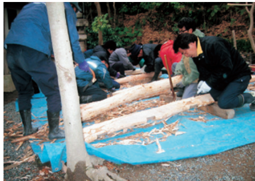
丸太橋削り作業
