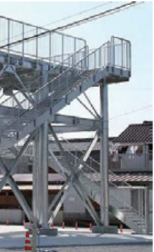
「災害対応とバリアフリー化の推進」として、津波避難タワーの設置（湘南海岸公園への設置予定の写真）和歌山県田辺市の例
