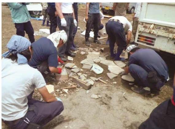
鉄平石を加工した石貼り
