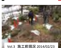
Vol.3 施工前現況 2014/02/23
