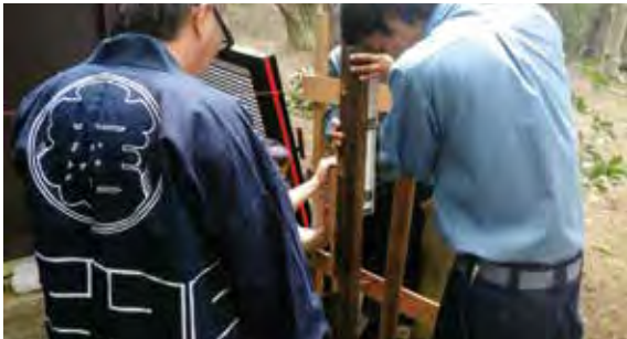
丁張りをを用い正確に柱を立て入れる
