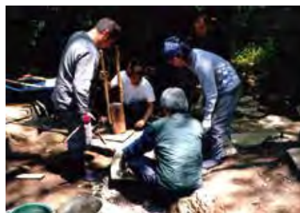
川田氏指導による丹波大板の据え付け
