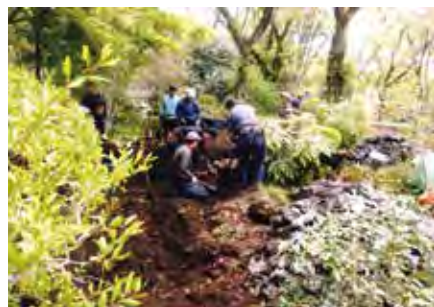
敷地内の景石、飛石、敷石、低木類等を撤去移動
