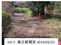
Vol.3 施工前現況 2014/02/23
