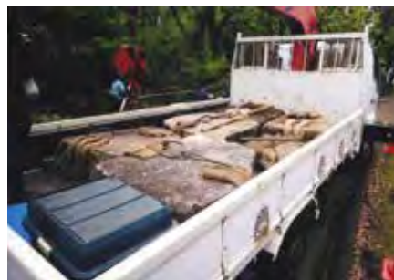
踏石に使う厚さ1尺の木曽石大板の現場搬入
