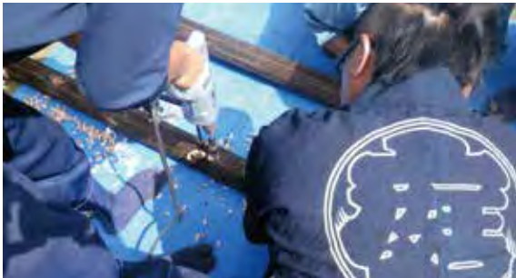
7分竹の胴縁が上手く収まるよう、幅25mm、深さ40mmの ホゾ穴を電動ドリルで直角にあける
