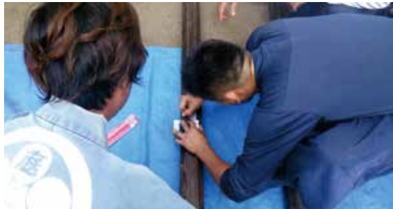
スコヤ、定規を使い、正確に墨付けをする
