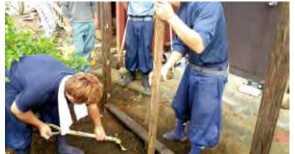
無目板がたわむのを防ぐため、束柱を据える
