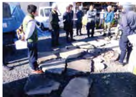
荒川氏の資材置場にて丹波の特板、大板の据え方を全員で検討
