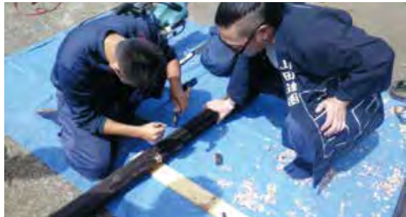
無目板が上手く収まるよう、ノミで正確に欠きを入れる
