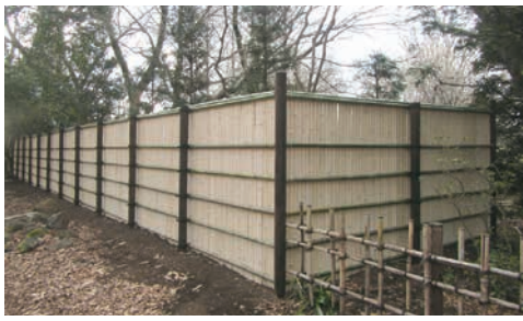
建仁寺垣の改修後
