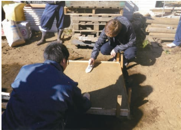
〈エコグロブシャワー工法〉木ゴテで仕上げる
