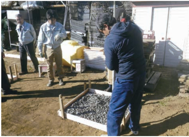
三工法とも碎石を敷き転圧する
