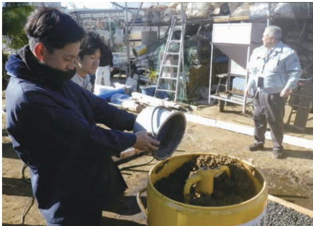
〈エコグロブ練り工法〉ミキサーで材と水を練り合わせる
