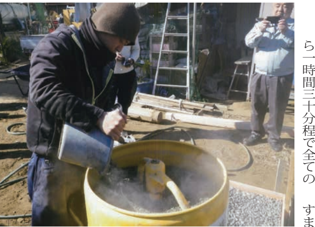
〈トースイエコグロブ〉ミキサーで粉材と骨材と水を練り合わせる
