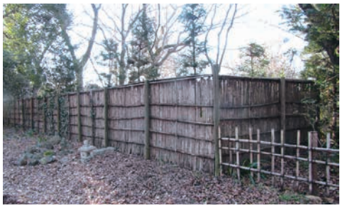
建仁寺垣の改修前
