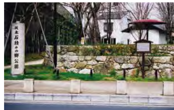
比叡山坂本駅前の穴太積み 石材は枯渇して入手がむずかしい地元の白石
