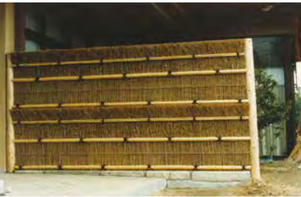
大徳寺二段垣 上下一ヶ所ずつ節を揃え節から出る小穂で渦巻模様をつくる
