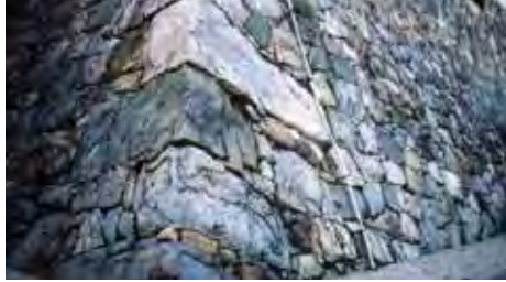
自然石での力強い算木積みは 高度な石の技を有する証石を知りつくした石垣師の存在が嬉しい 名古屋城
