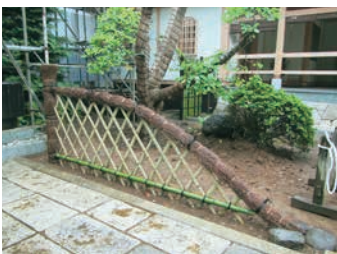
黒穂での玉縁巻き上げ施工後
