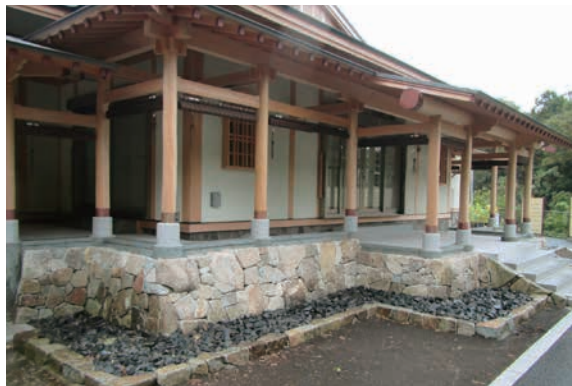
客殿石積み完成状況
