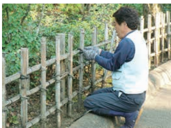
県立相模原公園 四つ目垣の補修
