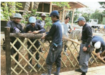
黒穂での玉縁巻き上げ施工中
