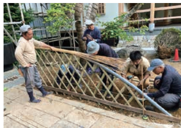
黒穂での玉縁巻き上げ施工中
