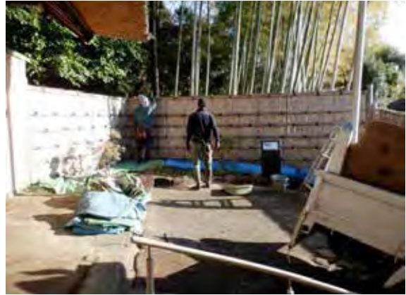
既存垣の解体
