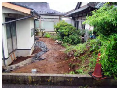
中庭の造園工事予定地
