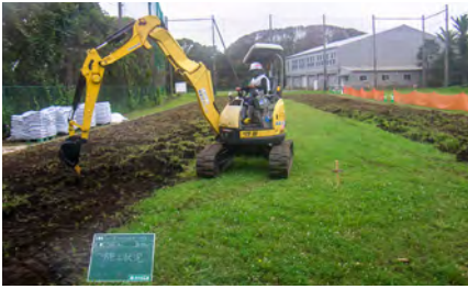
土壌改良・攪拌施工中
