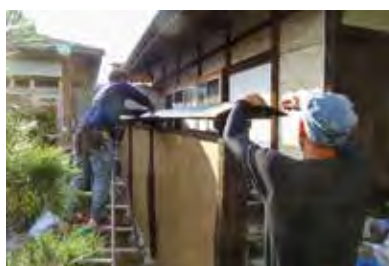
屋根の防水処理
