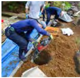
立て込み穴掘削
