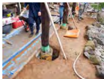
ポイド管、コンクリート根巻き
