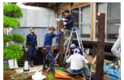
柱の立て込み
