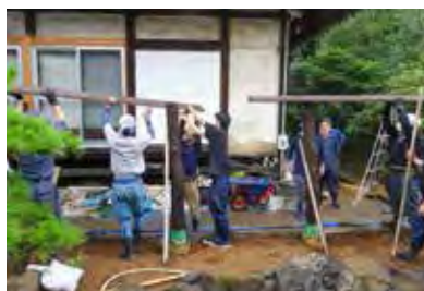
屋根板の取付
