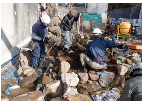
2月10日 流れ護岸作業
