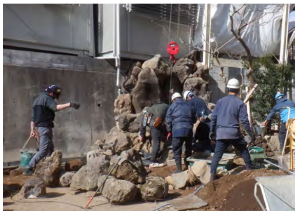
2月11日 滝口仕上作業
