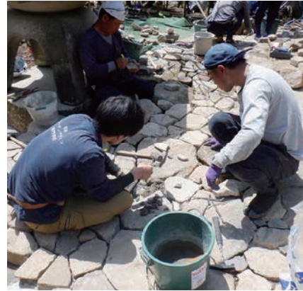
舞岡 延段施工中
