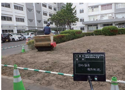
目砂散布転圧
